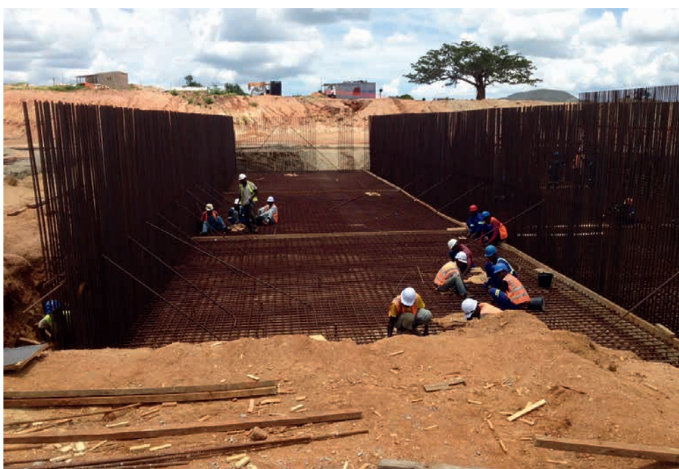
Nacala-Projekt – Bau des neuen Speicherbeckens und Pumpstation
