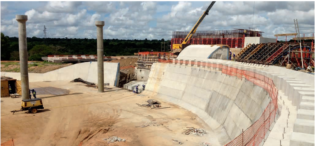
Erhöhung des Nacala-Damms zur Hochwasserentlastung
